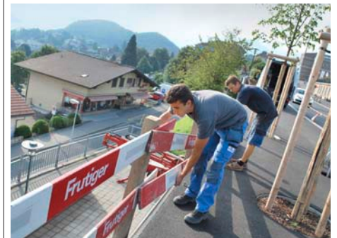
Die letzten provisorischen Abschränkungen wurden gestern abgebaut und an deren Stelle die finalen Meter Geländer montiert. Nicola Salvati (vorne) und Marc Bortor von der lokalen Firma Schlup & Partner Metallbau führen die abschliessenden Arbeiten an der Spiezer Terrasse aus.
