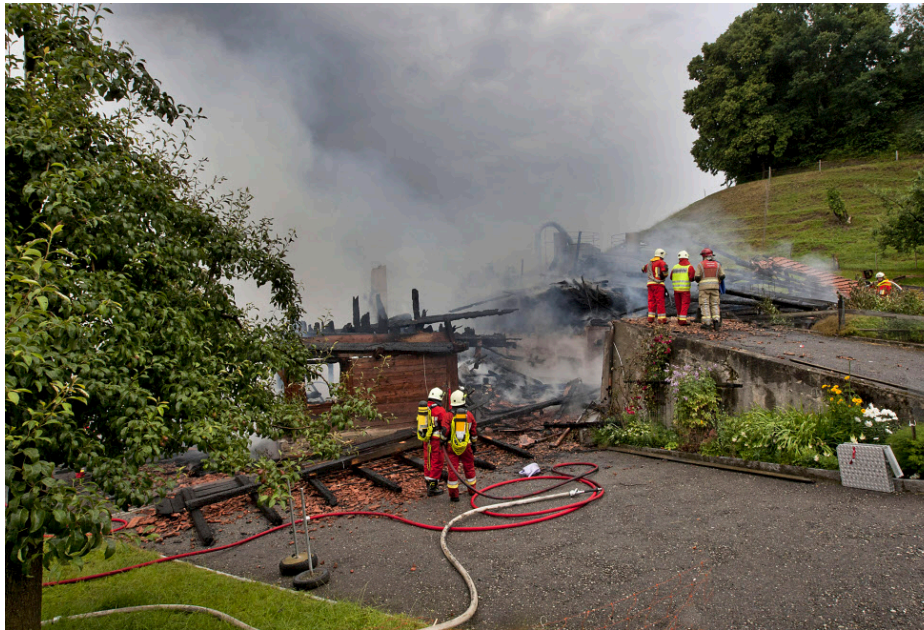
Nur noch eine Brandruine übrig: Nach einem Blitzeinschlag wurde das Wohnhaus mit Ökonomieteil von den Flammen zerstört.
